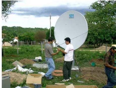
APCOB, instalación de satélites
