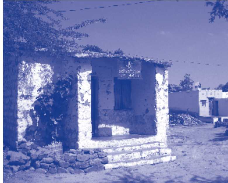
Edificio de un anganwadi en Poompuhar
