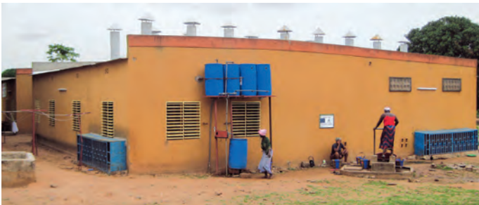
Figure 2.1. Entreprise avec 16 séchoirs
