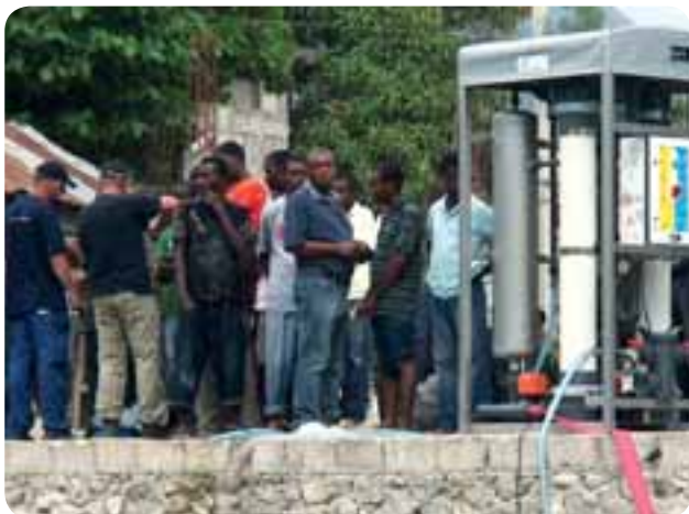
De plaatsing van een waterzuiveringsinstallatie in een van de zwaarst getroffen gebieden in Haïti.
