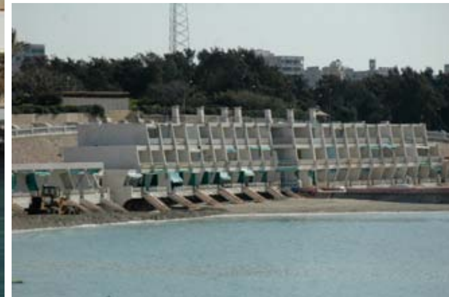
Semiramis cabins كبائن سميراميس
