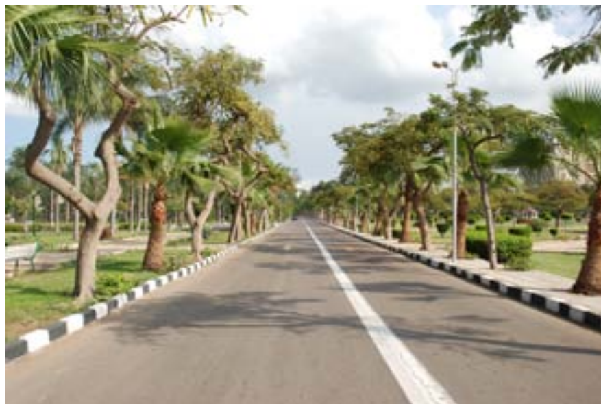
Entrance road طريق المدخل الرئيسي
