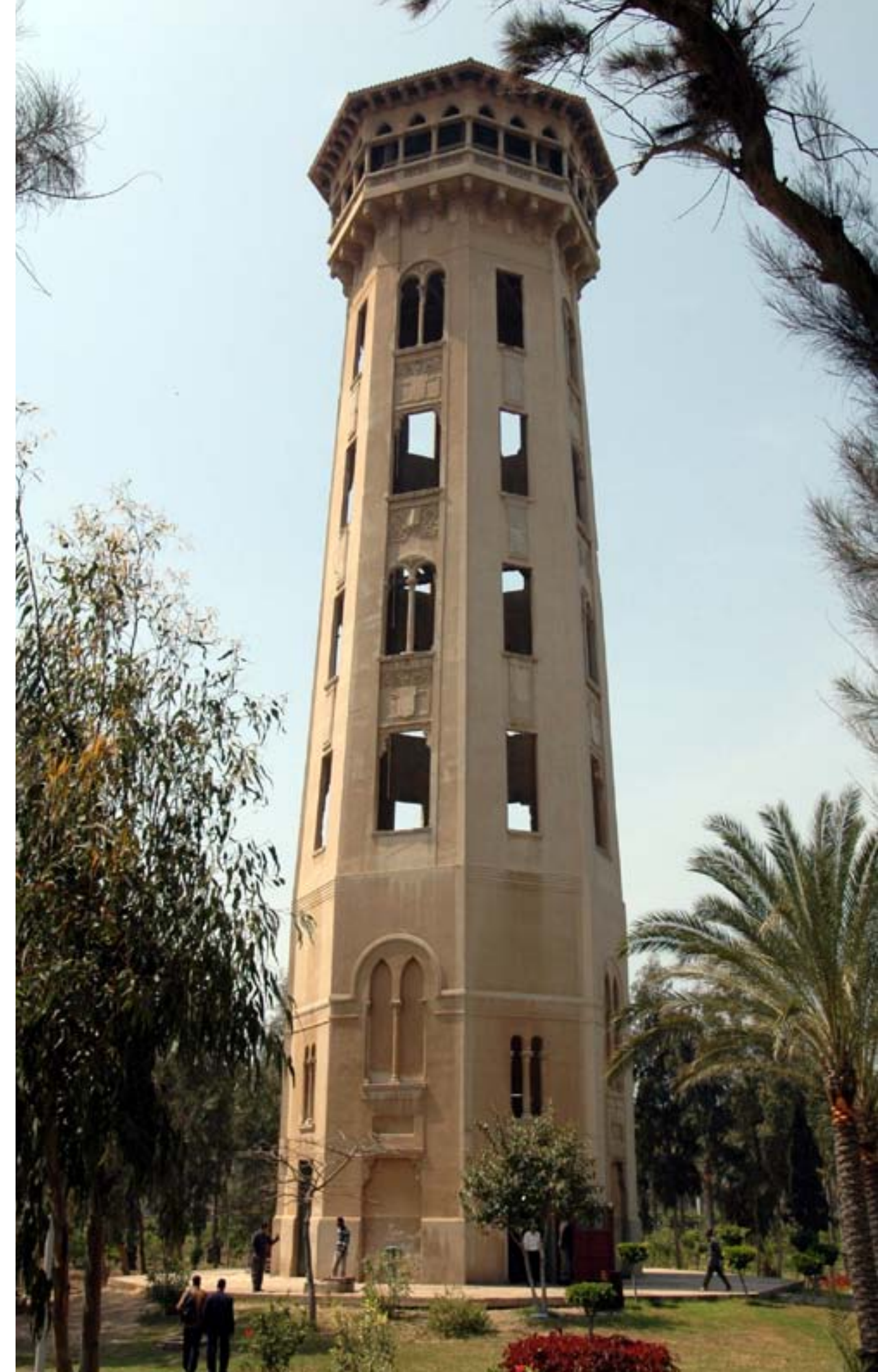
The Water Reservoir خزان المياه
