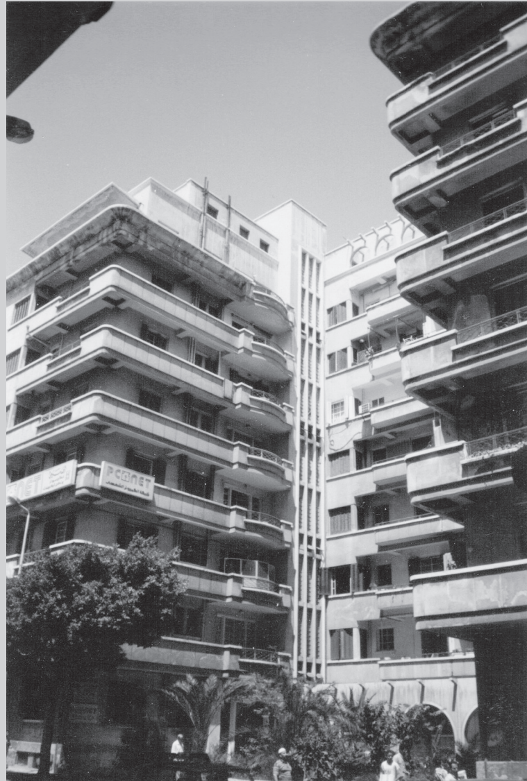
L'immeuble H côté ouest
