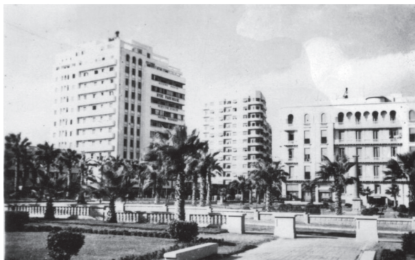
L'immeuble Heikal près de la Gare de Ramleh, à l'intersection de l'Avenue Alexandre le Grand et de la rue Amine Fikry.
